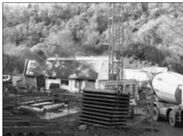
Dans le cadre de l'interconnexion des réseaux, des travaux de construction d'une station de pompage et d'un imposant réservoir sont en cours, au Rocher du Corbeau. Le chantier devrait être clos fin février.
